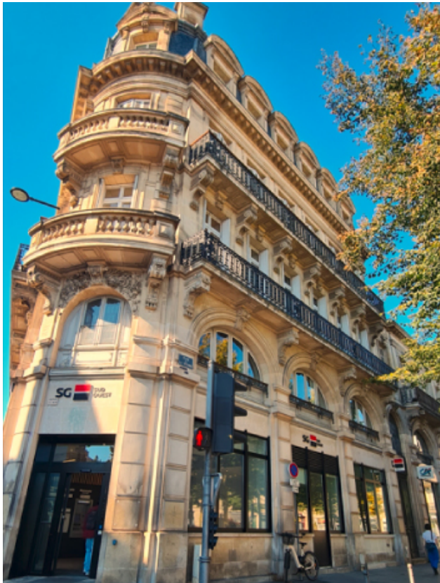
Cours Aristide Briand - Bordeaux (33)
