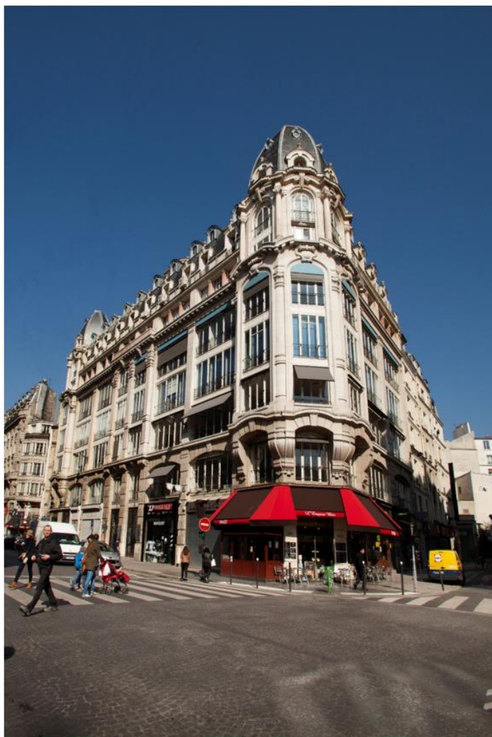
Rue Réaumur – Paris (2 e )
