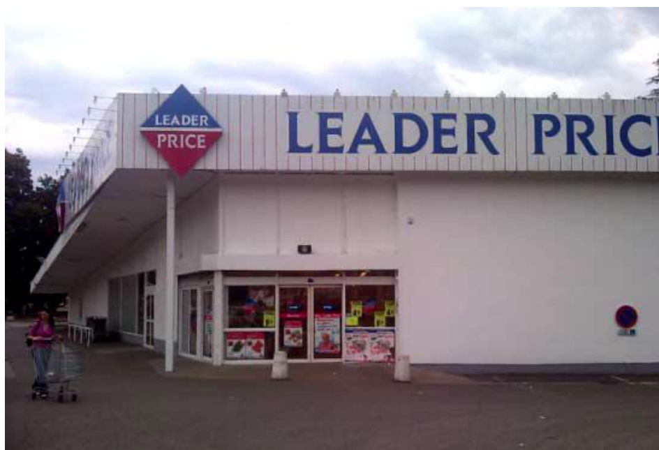
Rue Pierre Vincendon – La Tour du Pin (68)
