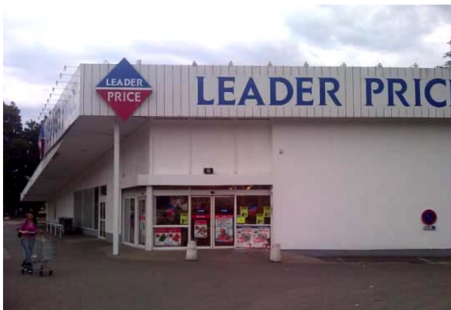
Rue Pierre Vincendon – La Tour du Pin (68)
